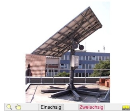
Nachgeführte Systeme – Zweischsige Nachführung
